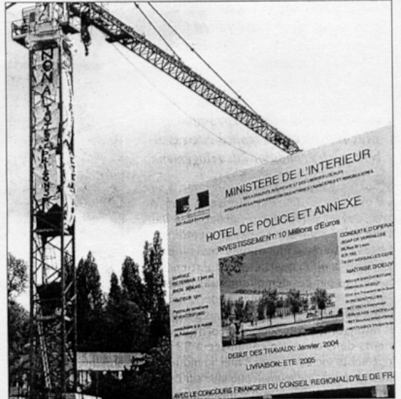
Une dizaine d'opposants à la construction du centre de rétention administrative a occupé la grue du chantier en espérant ne pouvoir y être délogés.
